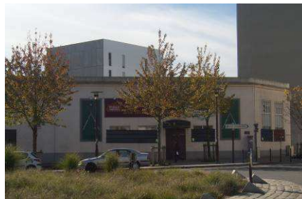
PROJET MC2 EN COURS DE CHANTIER DR POUGET CONSULTANTS
