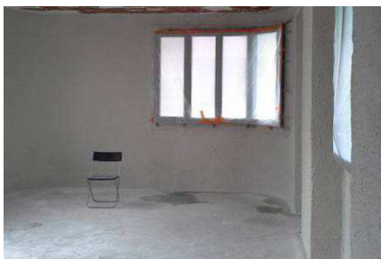
R'FILTER ET PLAFER MAX 737 SUR MUR - DR SINIAT
