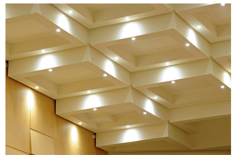
Caissons de L. 4,30 x l. 4,30 m en PRÉGYPLAC BD 25 Photographe : YVES SOULABAILLE - DR SINIAT
